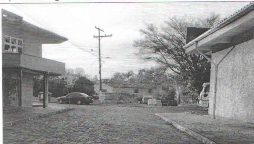
Fotos dos locais (Rua Domingo Kalfels e Rua Albino Neis)
